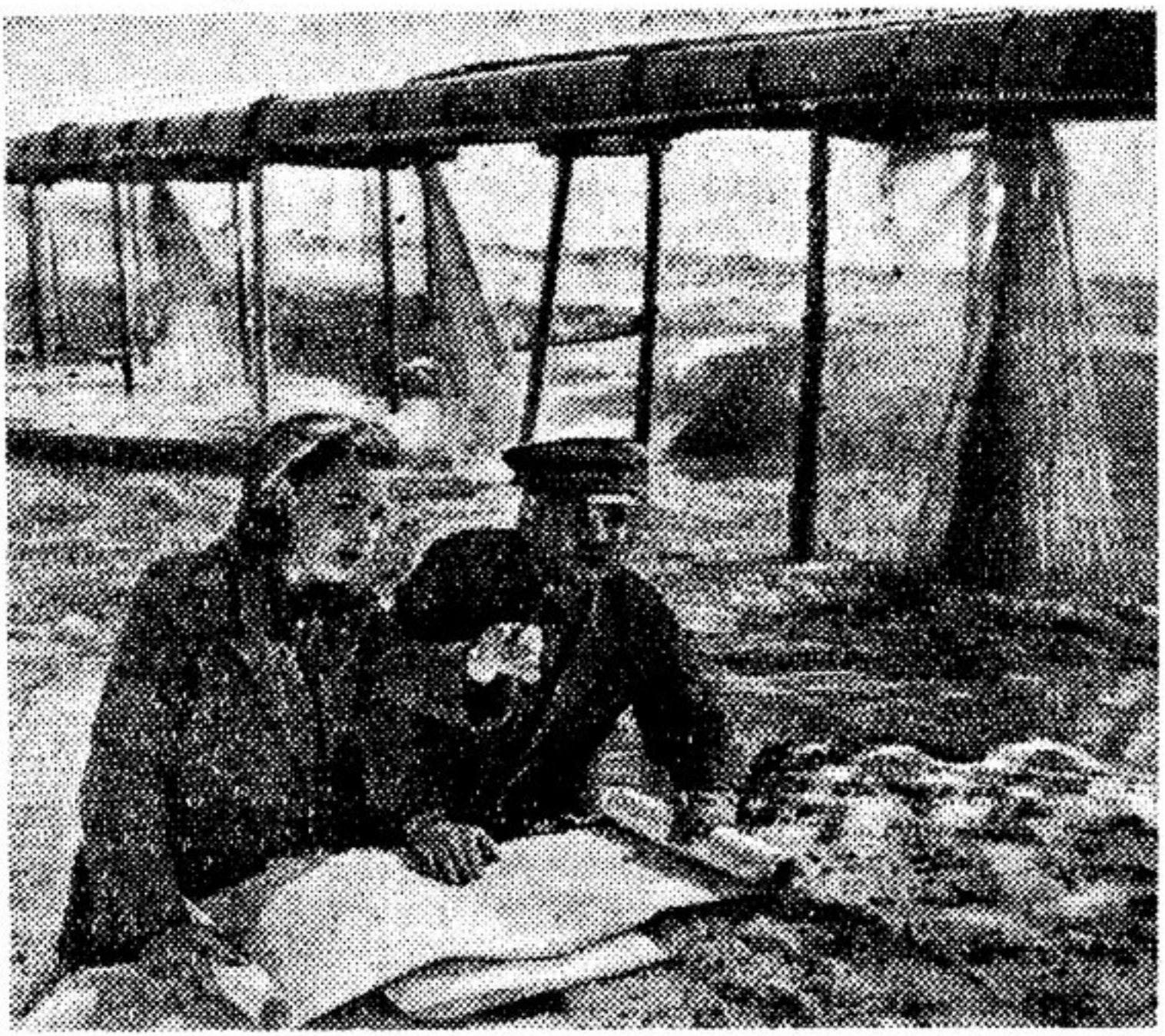
На строительстве Цимлянского водохранилища. Прораб первого участка молодой инженер-гидростроитель А. Борженко и начальник участка Т. Прошкин наблюдают за намывом земляной плотины.
